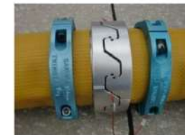
可搬型ホース（150A）接続後
