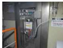
④ 復水ビット入口扉
