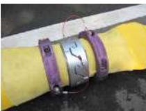
③ 可搬型ホース接続（接続後）
