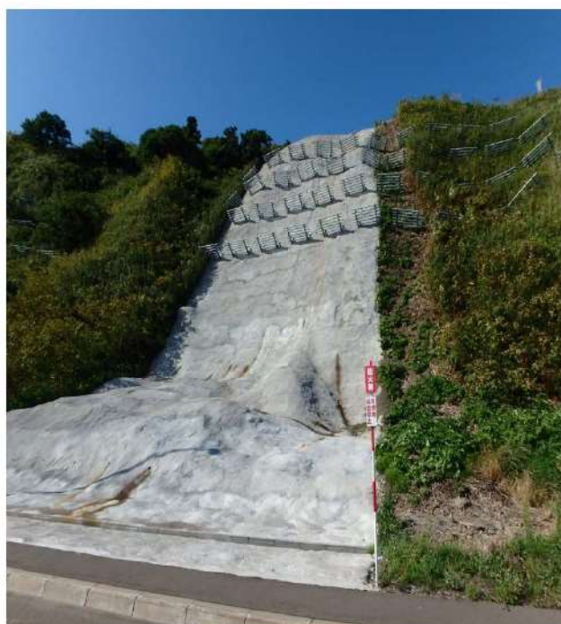
図 1 防火帯モルタル吹付工の施工例
