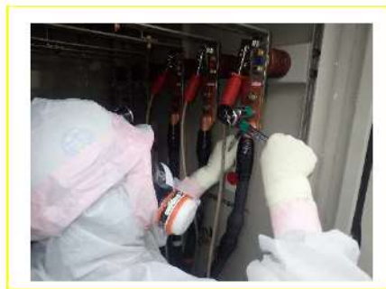
号炉間連絡ケーブル接続 （屋外）
