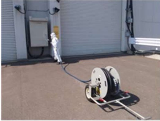
高圧ケーブル敷設 (屋外)
