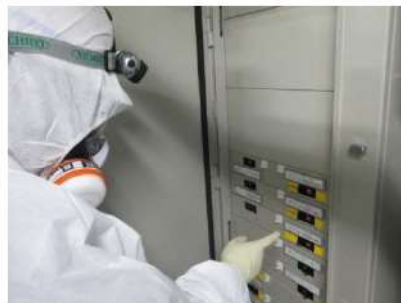
不要直流負荷の切離し操作 (安全補機開閉器室) (原子炉補助建屋T. P. 10. 3m)
