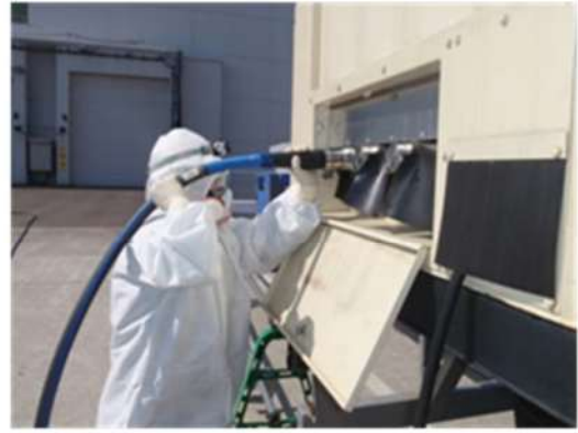
高圧ケーブル接続 (屋外)
