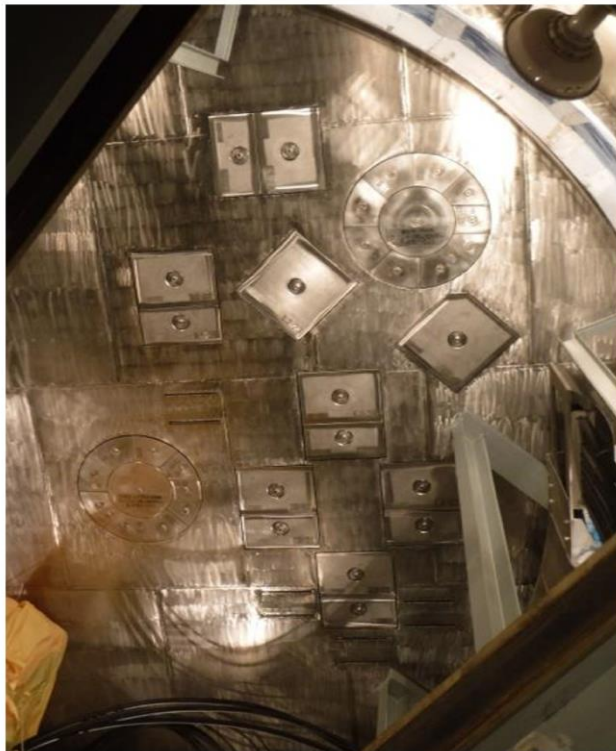
図 1-3 コリウムシールド外観
