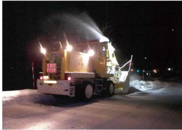
第4-1図 重機による除雪作業 (1)
