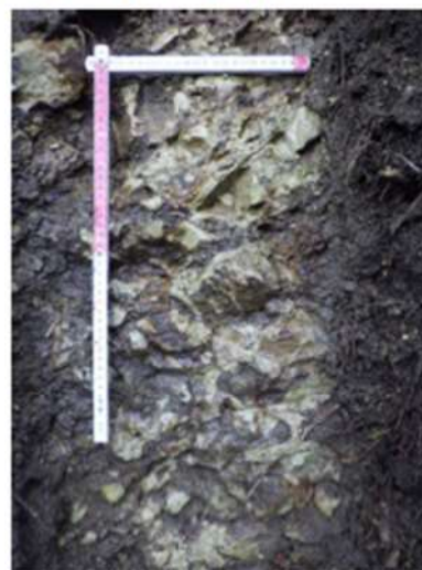
P5 防災科研調査において地滑り土塊とされる箇所に分布する沢の露岩状況 堅硬な岩盤(凝灰岩)が認められる。
