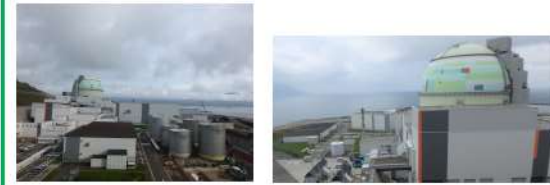
2号炉タービン建屋屋上
