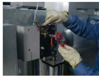
(空気作動ダンパ閉作業イメージ)
