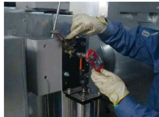
(空気作動ダンパ閉作業イメージ)
