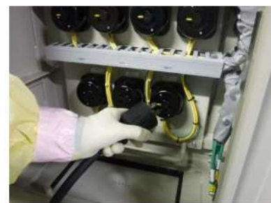
電源ケーブル接続 (周辺補機棟 T. P. 24. 8m)
