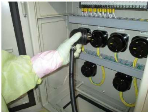
原子炉格納容器水素濃度監視電源操作 (周辺補機棟 T. P. 24. 8m)
