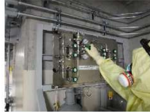
加圧器逃がし弁操作用 可搬型窒素ガスボンベ 供給操作 (周辺補機棟 T.P. 17.8m)
