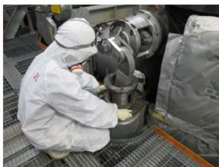
主蒸気隔離弁増締め操作 (周辺補機棟 T.P. 33. 1m)
