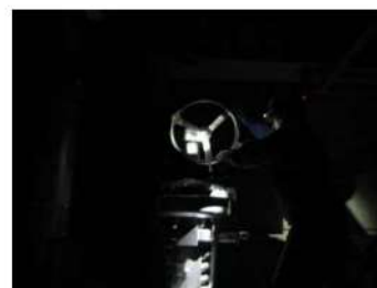
主蒸気逃がし弁開放操作(照明消灯時) (周辺補機棟 T.P. 33. 1m)
