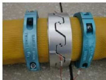
可搬型ホース（150A）接続後
