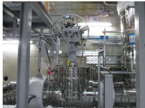
3 A-余熱除去ポンプ入口弁 (3V-RH-005A)
