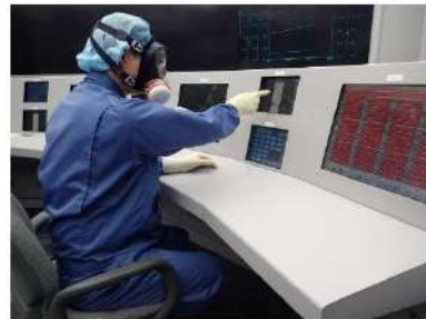
加圧器逃がし弁開操作 (中央制御室)
