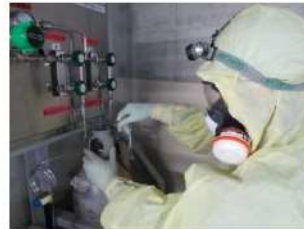
加圧器逃がし弁操作用 可搬型窒素ガスボンベ 供給操作 (周辺補機棟 T.P. 17.8m)
