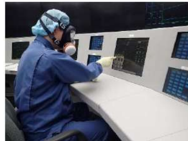
主蒸気逃がし弁開操作 (中央制御室)
