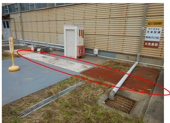
撮影方向③ 空気系統用冷却設備付近グレーチング
