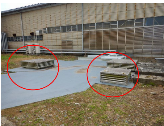
撮影方向⑥ B トレンチ出入口付近グレーチング
