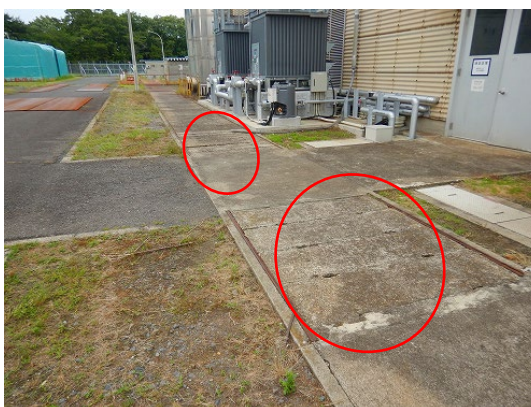
撮影方向④ 空気系統用冷却設備付近グレーチング
