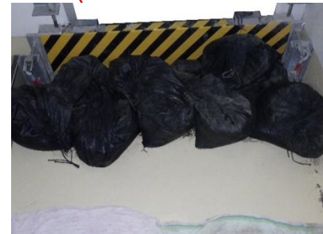
土嚢の設置状況
