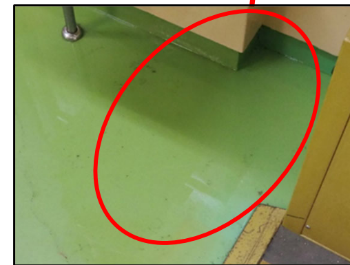
セル操作室 (第2種管理区域) 出入口扉の壁付近
