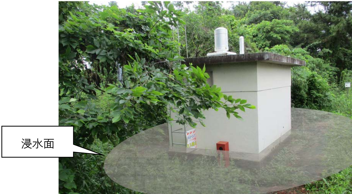
P-11 局舎周辺の浸水状況（担当者からの聞き取りに基づく再現）
