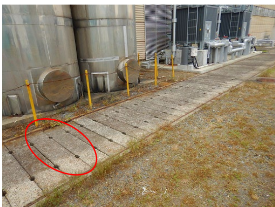
撮影方向⑤ 空気系統用冷却設備付近グレーチング
