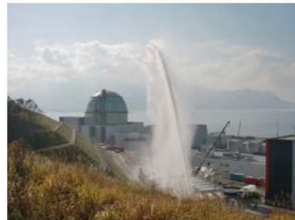
第10図 直状放射による放水状況
