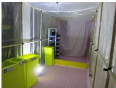
可搬型照明①
