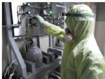
窒素供給操作(バルブパネル操作)
