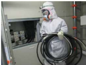
可搬型直流変換器 直流出力ケーブル敷設作業 (安全補機開閉器室) (原子炉補助建屋 T.P. 10. 3m)
