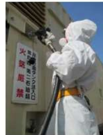
可搬型代替電源車の給油口への 接続 (クイックカブラ式) (可搬型代替電源車) (屋外 T.P. 31m)
