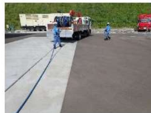
号炉間連絡予備ケーブル敷設 (屋外T. P. 31m)
