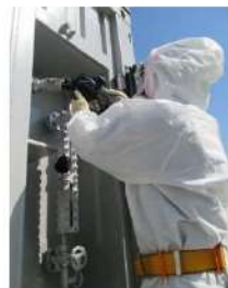
代替非常用発電機の給油口への 接続 (クイックカブラ式) (代替非常用発電機) (屋外 T.P. 31m)
