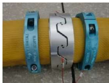
可搬型ホース（150A）接続後
