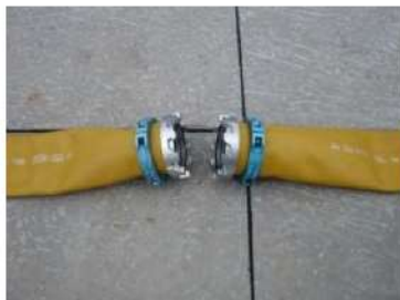
可搬型ホース（150A）接続前
