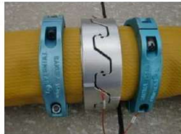
可搬型ホース(150A)接続後
