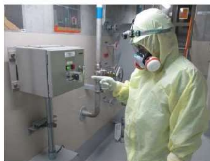
1次系補給水ポンプによる注水 (原子炉補助建屋 T.P. 17.8m)
