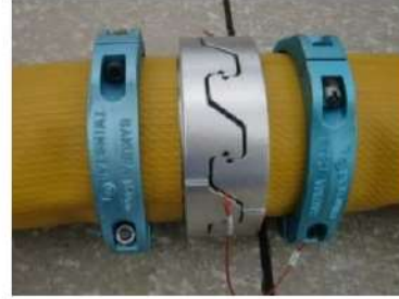
可搬型ホース (150A) 接続後
