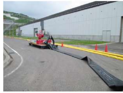
放水砲設置 (屋外 T. P. 10. 3m)
