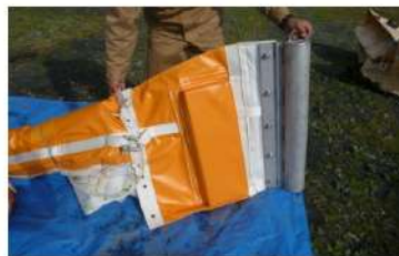
荷揚場シルトフェンス端部
