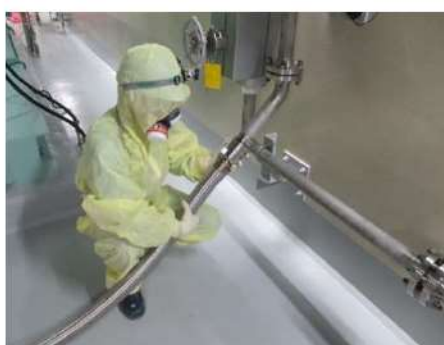
自己冷却水用可搬型ホース接続 (原子炉補助建屋 T.P. -1.7m)
