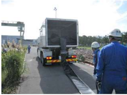
ホース延長・回収車(放水砲用)による ホース敷設 (屋外 T.P. 10.3m)
