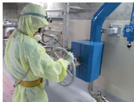
B-充てんポンプ自己冷却運転系統構成 （原子炉補助建屋 T.P. 14. 5m）
