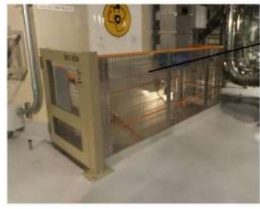
(写真A) 階段開口部に設置したパンチングメタル
