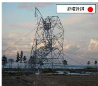
津波による隣接鉄塔の倒壊に伴う送電鉄塔の倒壊事例 ※2
