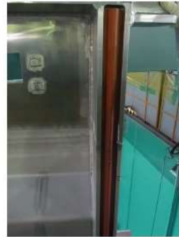
ゲートパッキンの装着状況
