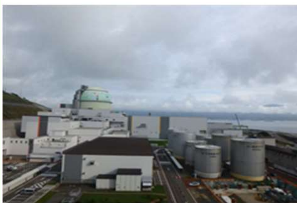
2号炉タービン建屋屋上
