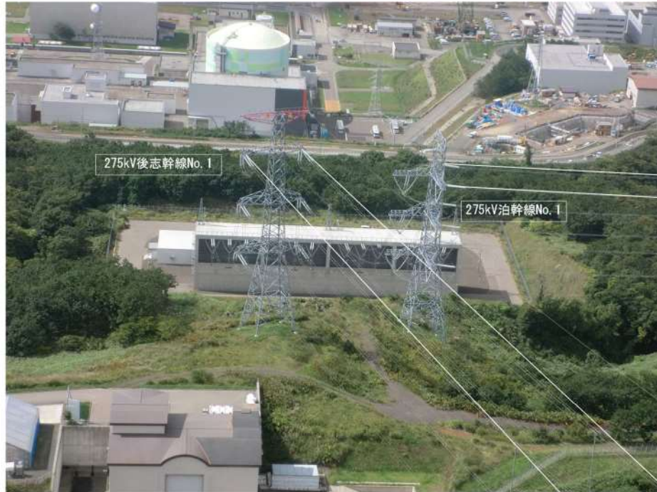
第 2.2.3.3 図 ①近接箇所の現地状況 (1/3)
