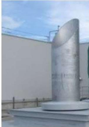
図3 主蒸気安全弁排気管の設置状況
