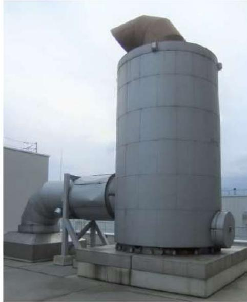
図2 ディーゼル発電機排気消音器及び排気管
