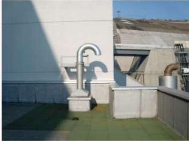
図1 タービン動補助給水ポンプ排気管の設置状況
