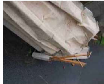
飛散した折板屋根の状況
