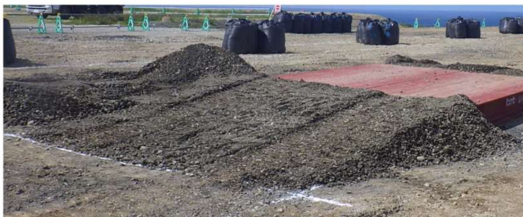
段差復旧用の砕石イメージ
