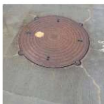
マンホール蓋
