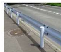
ガードレール
