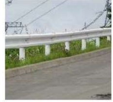
ガードレール
