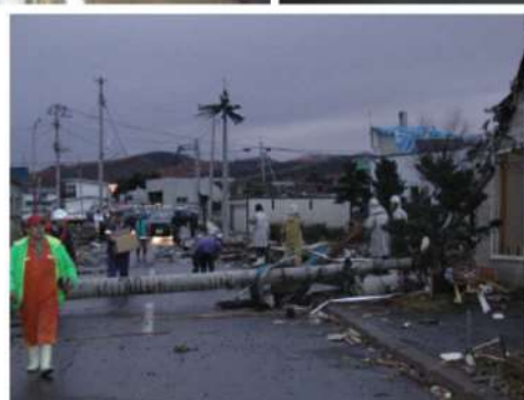
(電柱，道路標識の折損)
