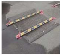
マンホール蓋
