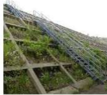
階段（H鋼製）
