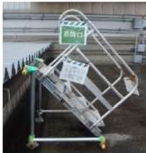
階段（単管パイプ製）
