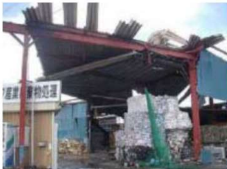
折板の損傷
