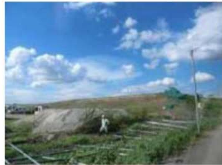
フェンスの被害
