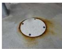
マンホール蓋
