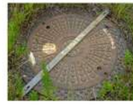
マンホール蓋
