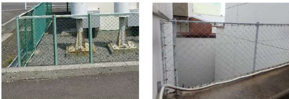
図33 泊発電所におけるフェンスの状況
