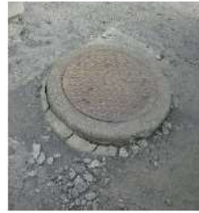
マンホール蓋
