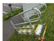
階段（単管パイプ製）
