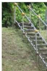
階段（単管パイプ製）
