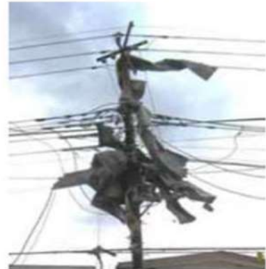
飛散した折板屋根の状況
