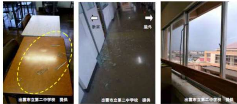
(1) 教室 (2) 廊下 (3) 屋外に面した窓ガラス
