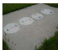
マンホール蓋
