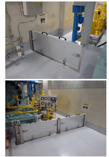
図5-4 止水板設置状況
