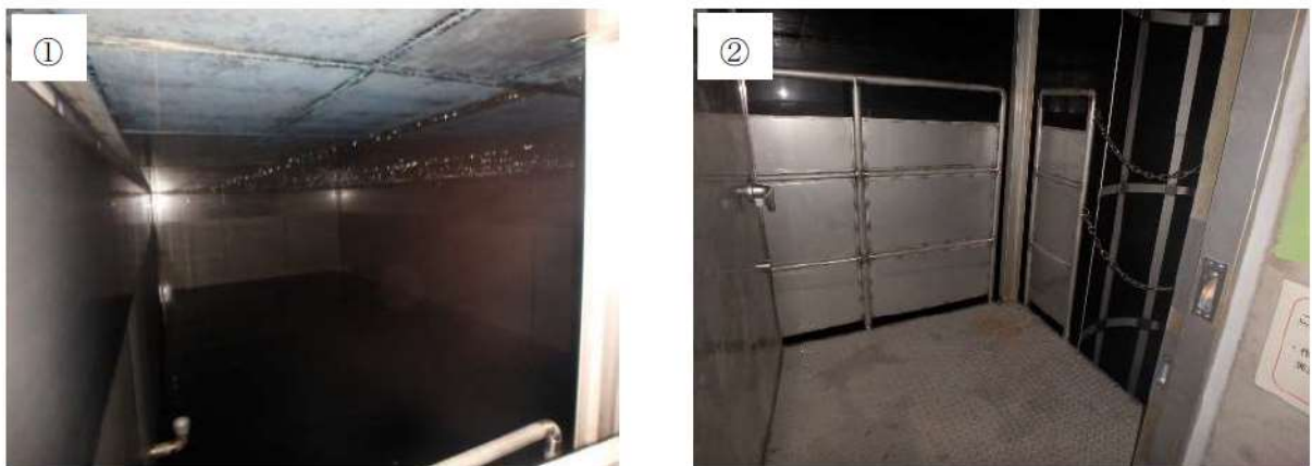
第 5-7 図：補助給水ピットの現場状況
