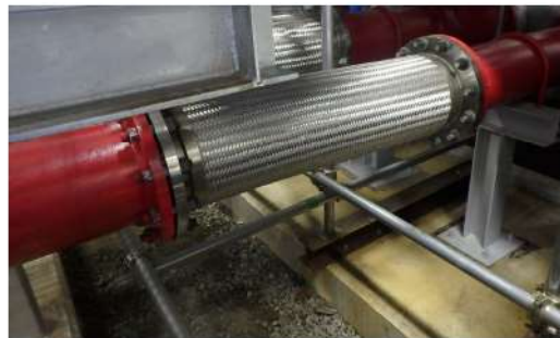
第 1-23 図：地震変位対策の実施例
