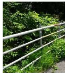
ガードパイプ
