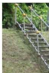
階段 (単管パイプ製)
