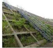
階段（H鋼製）
