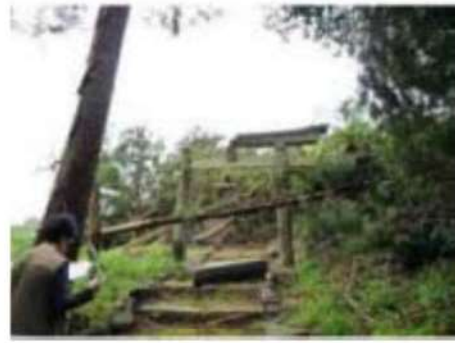
倒木の折損と鳥居の被害
