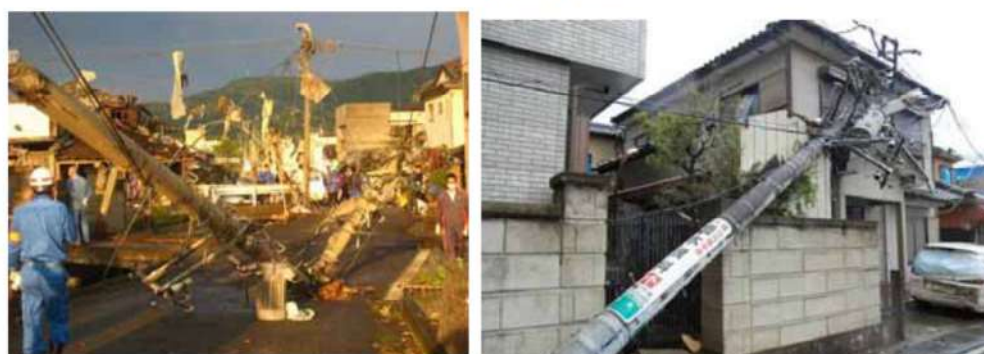
(電柱の折損, 傾斜)
