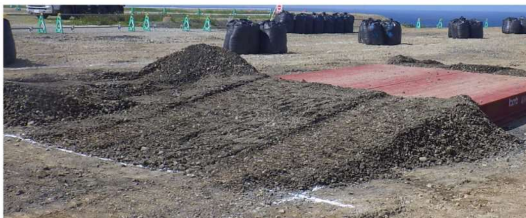
段差復旧用の碎石イメージ
