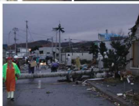
(電柱, 道路標識の折損)
