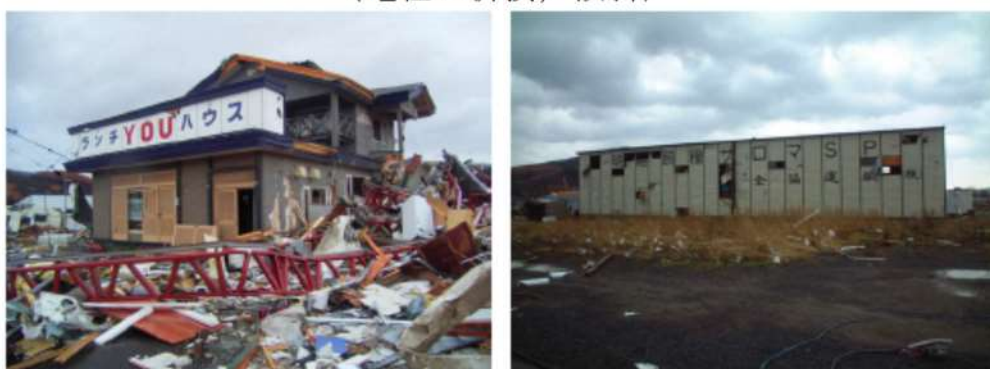
(建築物への飛来物の衝突痕)
