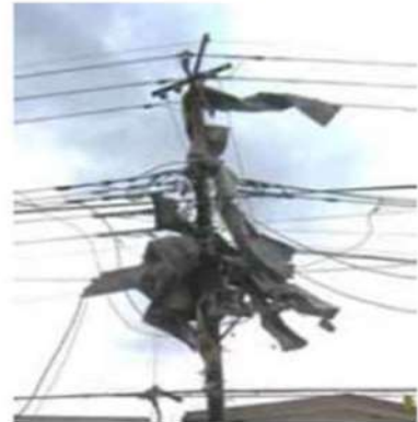
飛散した折板屋根の状況
