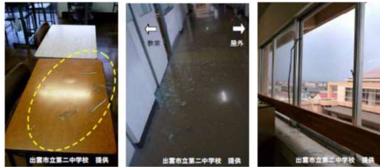
(1) 教室 (2) 廊下 (3) 屋外に面した窓ガラス
