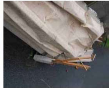
飛散した折板屋根の状況
