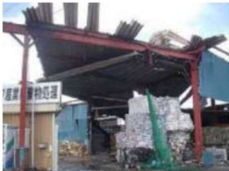
折板の損傷
