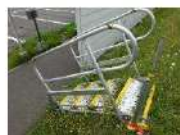
階段（単管パイプ製）
