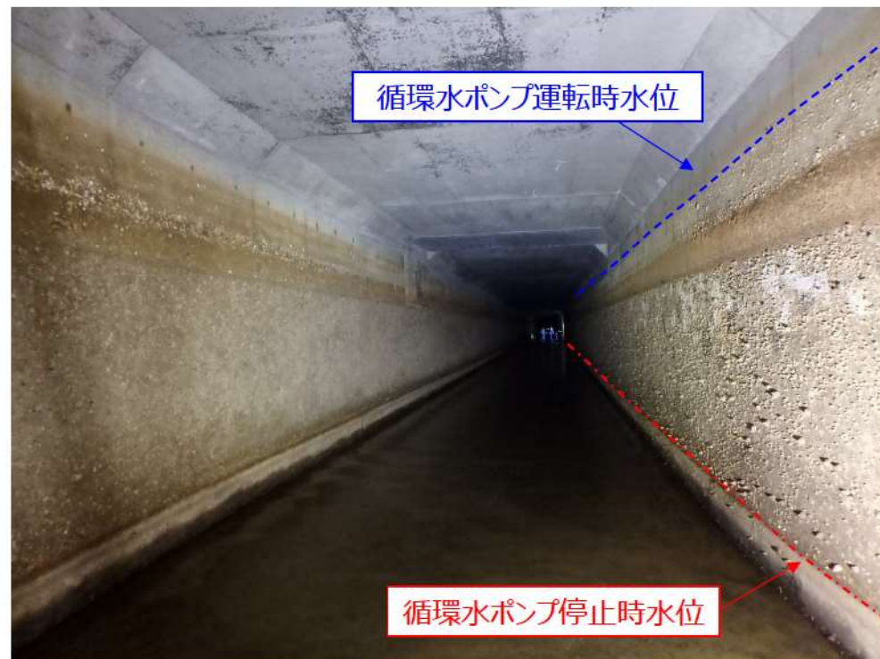
図1 1号炉放水路状況（2023年2月）
