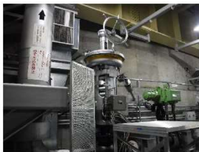
【図1 3B-主蒸気逃がし弁】
