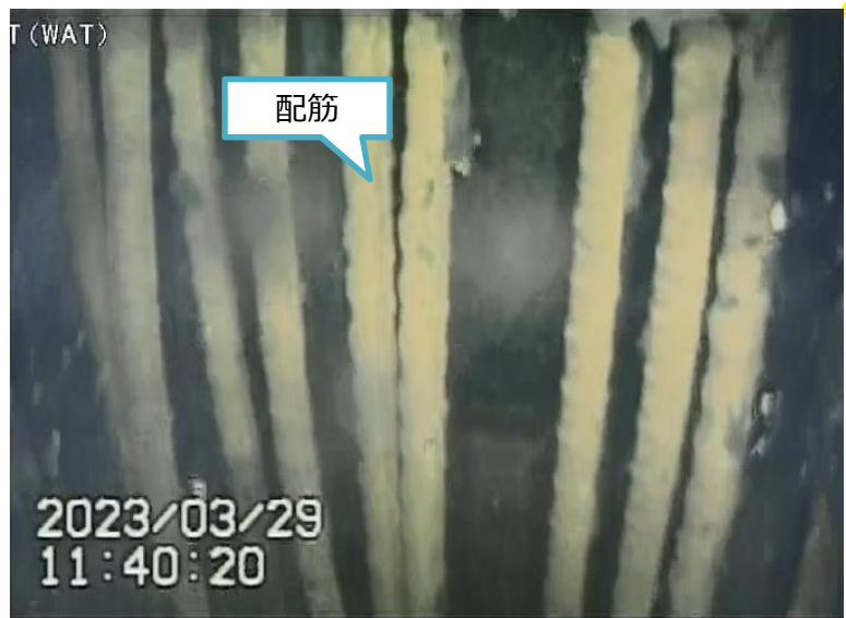
写真2.ペDESTAL内壁面部(下部)
