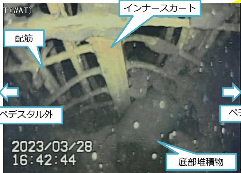
写真2.ペDESTAL開口左側配筋
