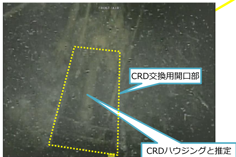
写真2. ペDESTAL内壁側のCRD交換用開口部の状態 (気中監視カメラで気中を撮影)
