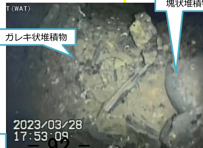
写真3. ペDESTAL内開口付近堆積物
