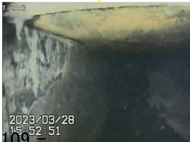
写真3 開口部内部の左側の壁の状態
