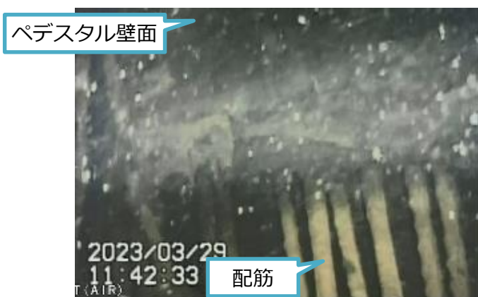
写真1. ポイント⑪ペDESTAL基礎部
