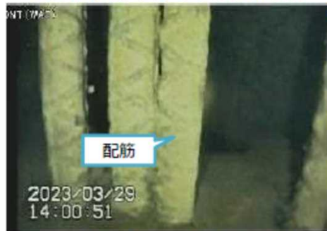
写真2. ポイント@ペDESTAL基礎部
