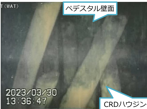
写真2. CRDハウジングと思われる構造物
