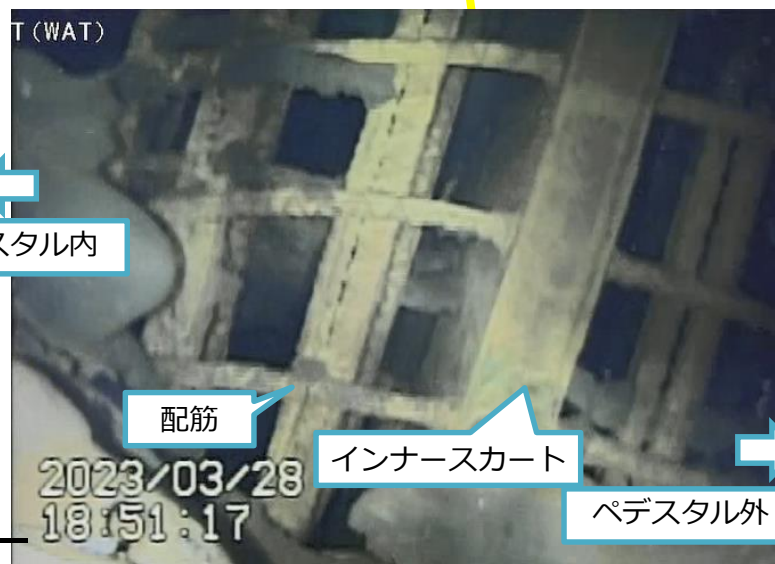
写真3.ペDESTAL開口右側配筋
