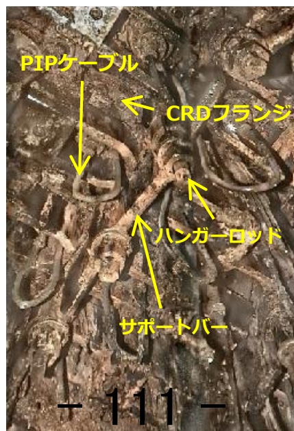
写真2. 2号機で確認されたCRD
