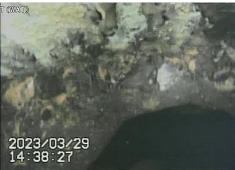
写真2 棚状堆積物の縁の状態 (その2)
