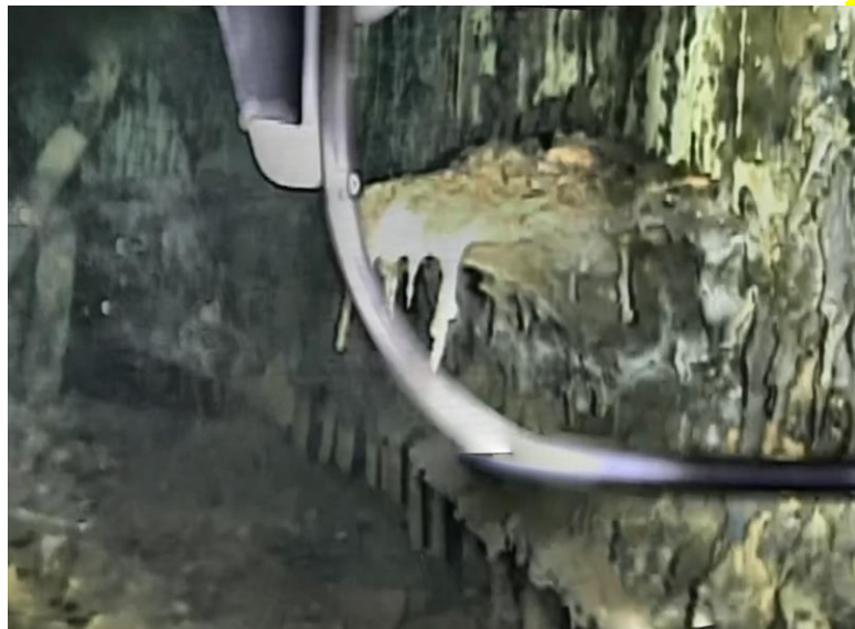
写真2 (パノラマ) 開口部右側の棚状堆積物
