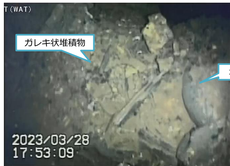
写真2.ペDESTAL内開口付近堆積物
