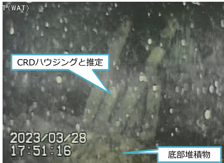
写真1. CRDハウジングと思われる構造物
