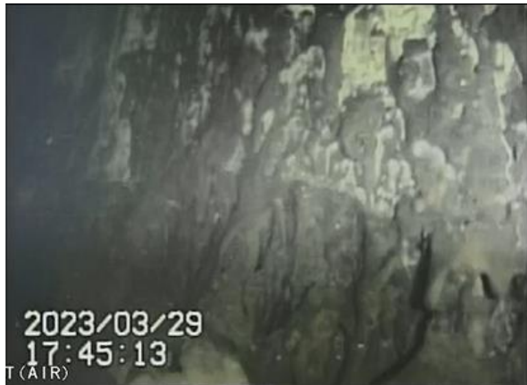
写真1 棚状堆積物のない壁面の状況
