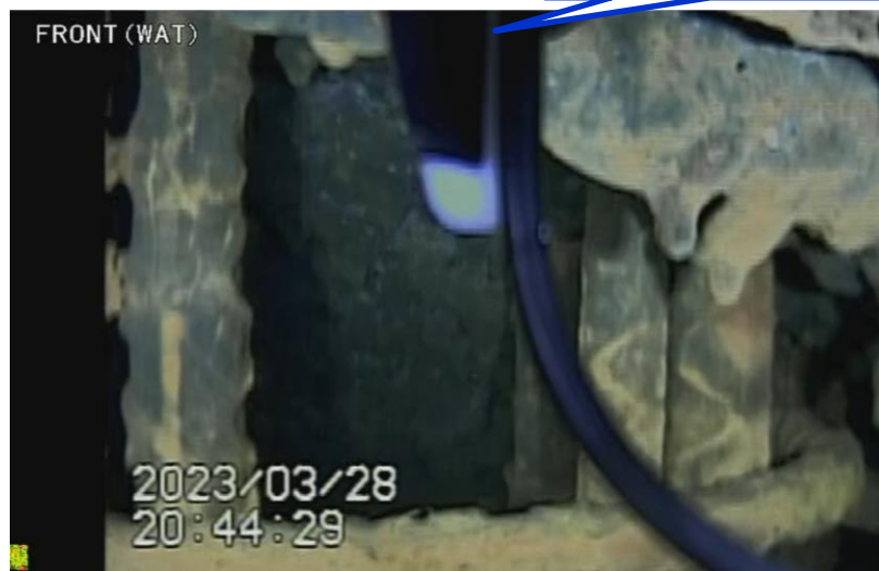
写真1. ペDESTAL開口部内から見えているコンクリート残存部
