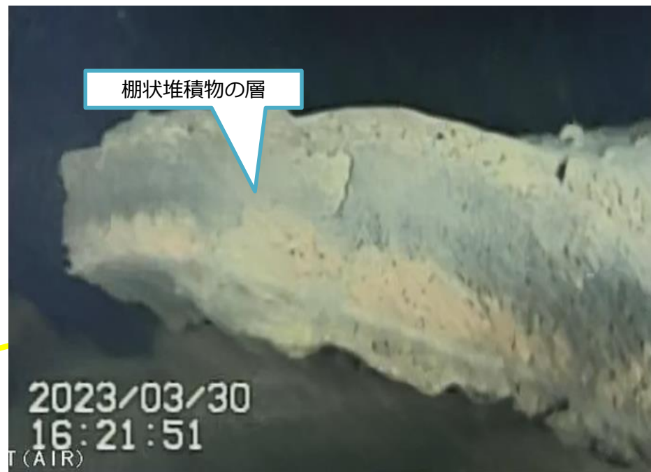
写真1. ペDESTAL外棚状堆積物断面
