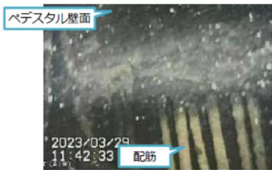
写真1. ポイント@ペDESTAL基礎部
