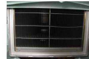
装置底部 (PAR入口給気口)
