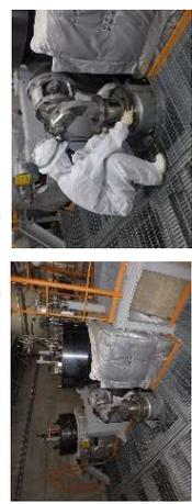
B-主蒸気隔離弁
