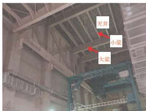
図 5.2.2 燃料取扱棟の屋根
