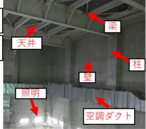
②使用済燃料ピット上部
