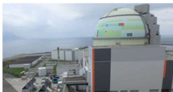
3号炉北東法面
