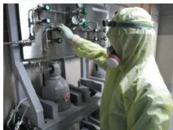
窒素供給操作(バルブパネル操作) (原子炉建屋 T.P. 40. 3m)
