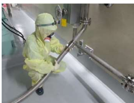
自己冷却水用フレキシブル配管接続 (原子炉補助建屋 T.P. -1.7m)
