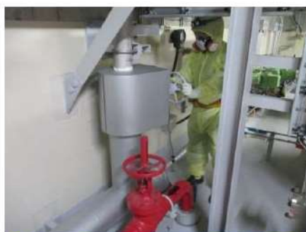
消火ポンプによる原子炉容器への注水系統構成 （運転員（現場）B） （原子炉補助建屋 T. P. 10. 3m）
