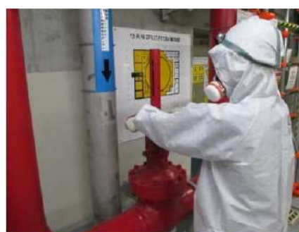
消火ポンプによる原子炉容器への注水系統構成 （運転員（現場）C） （原子炉建屋 T. P. 17. 8m）
