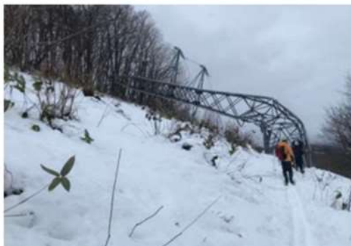
大雪による鉄塔倒壊事例 ※3
