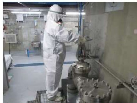
補助給水ピット水源切替 系統構成 (原子炉建屋 T. P. 10.3m)
