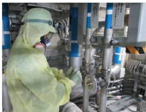
燃料取替用水ピット 補給ライン系統構成 (原子炉補助建屋 T.P. 10. 3m)
