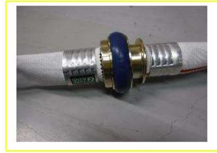
消防ホース (40 A) 接続後
