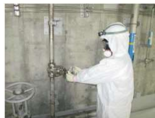
可搬型大型送水ポンプ車による原子炉
