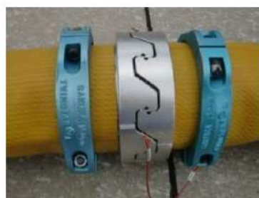
可搬型ホース（150A）接続後
