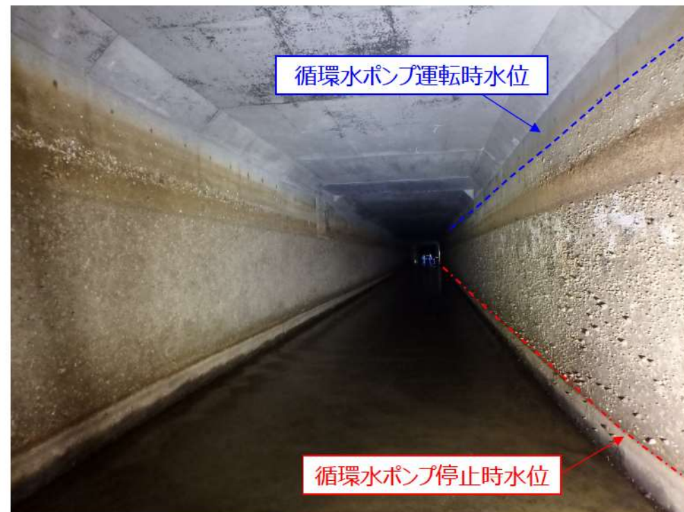
図1 1号炉放水路状況（2023年2月）
