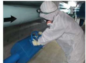
通水操作 (原子炉建屋 T.P. 2.3m)
