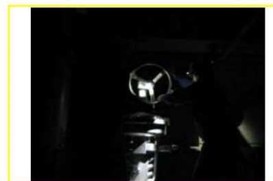
主蒸気逃がし弁開放操作(照明消灯時) (原子炉建屋 T.P. 33. 1m)
