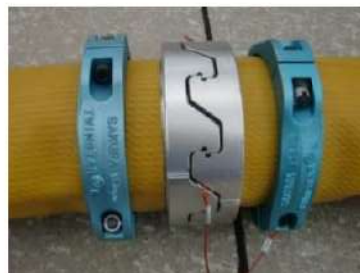
可搬型ホース（150A）接続後
