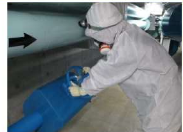
通水操作 (原子炉建屋 T.P. 2. 3m)
