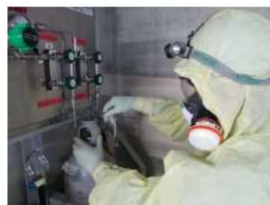
加圧器逃がし弁操作用 可搬型窒素ガスボンベ 供給操作 (原子炉建屋 T. P. 17. 8m)
