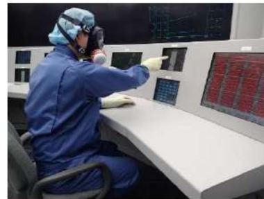
加圧器逃がし弁開操作 (中央制御室)
