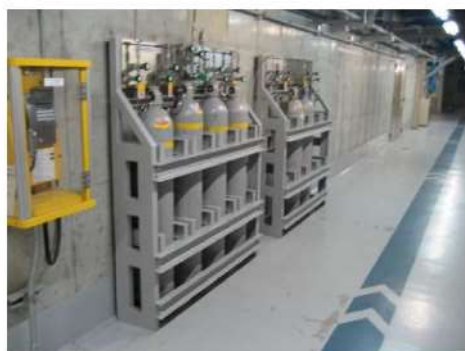
主蒸気逃がし弁操作用 可搬型空気ポンベ (原子炉建屋 T.P.10.3m)
