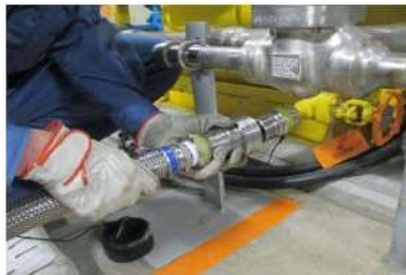
ホース接続操作（油タンク側） （原子炉建屋 T. P. 10. 3m）
