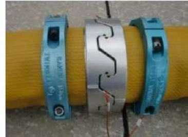
可搬型ホース (150A) 接続後
