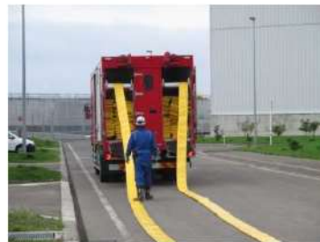
ホース延長・回収車 (送水車用) による可搬型ホース敷設 (屋外 T. P. 10. 3m)
