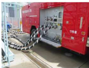
可搬型大型送水ポンプ車の設置 ポンプ車周辺のホース敷設 (屋外 T. P. 10. 3m)
