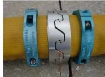
可搬型ホース (150A) 接続後
