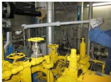
専用工具（蒸気加減弁開操作用）操作 （原子炉建屋 T. P. 10. 3m）
