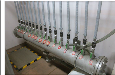
ヘッダー 1台のルーツブロウにより複数箇所から捕集するための集合部
