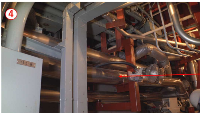
図7 原子炉補機冷却水系配管（ウレタン保温材）の設置状況
