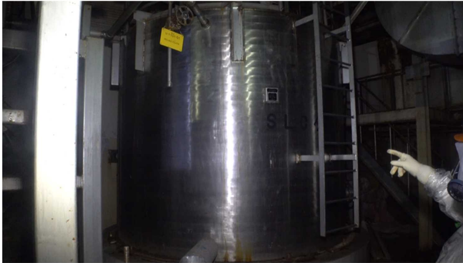
図 59 SLC タンク（北東側フロア）
