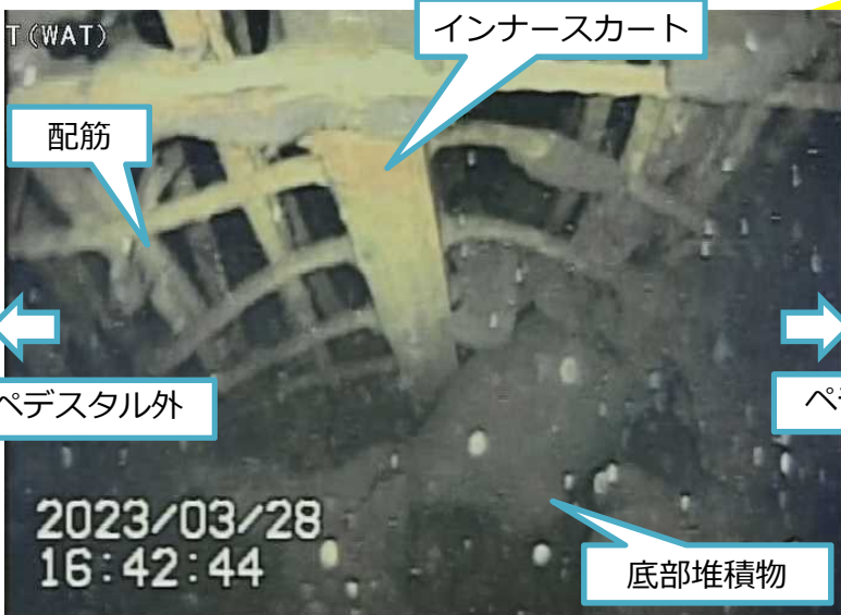
写真2.ペDESTAL開口左側配筋
