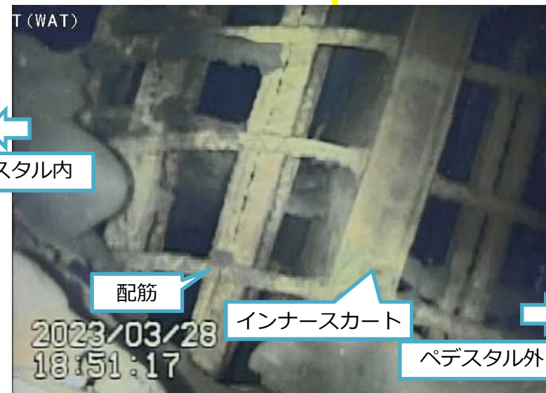
写真3.ペDESTAL開口右側配筋
