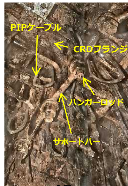
写真2. 2号機で確認されたCRD
