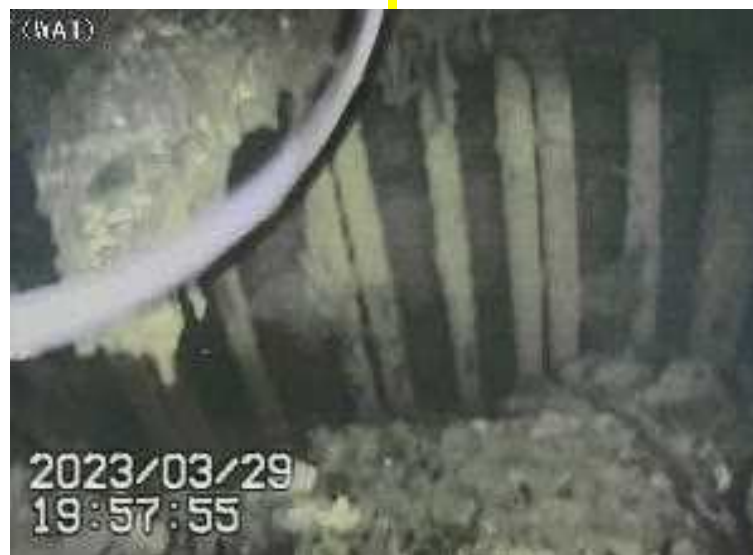
— 24 — 写真3 比較的に大きい棚状堆積物
