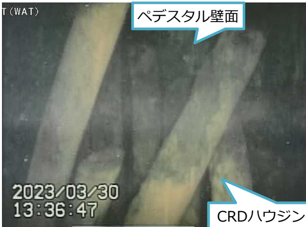
写真2. CRDハウジングと思われる構造物
