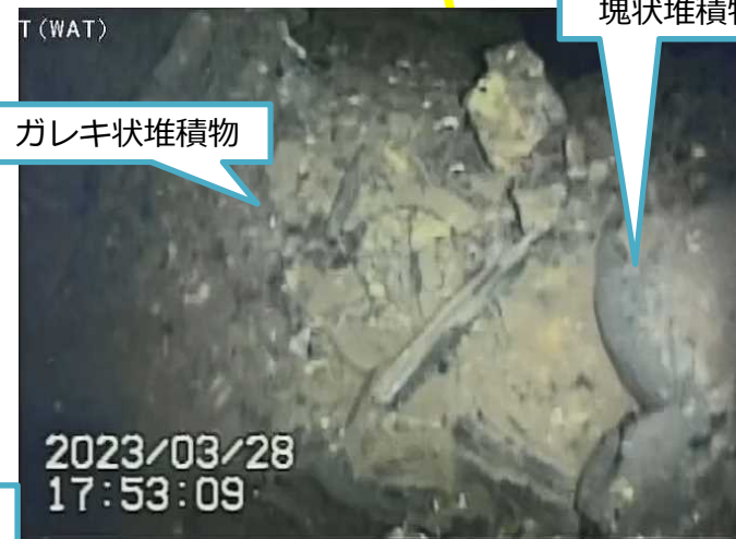
写真3. ペデスタル内開口付近堆積物
