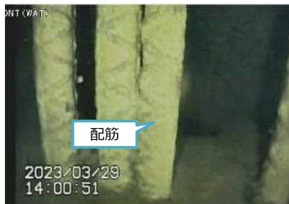
写真2. ポイント⑫ペDESTAL基礎部
