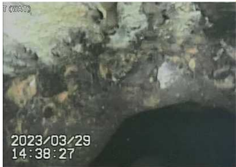
写真2 棚状堆積物の縁の状態 (その2)
