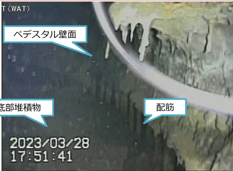
写真1.ペDESTAL内壁面部配筋
