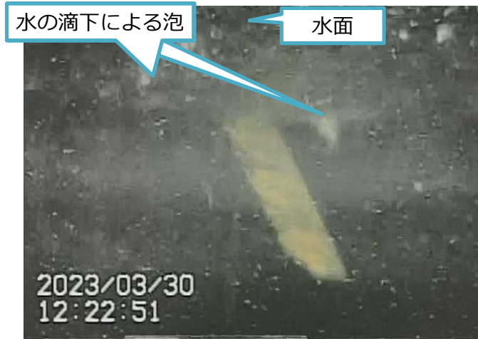
写真1. 炉注水停止前の水面の状況
