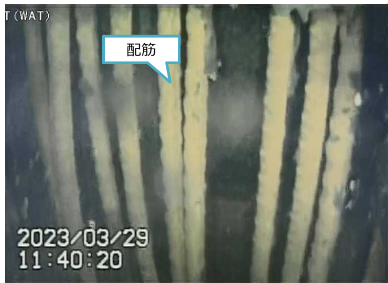
写真2.ペDESTAL内壁面部(下部)
