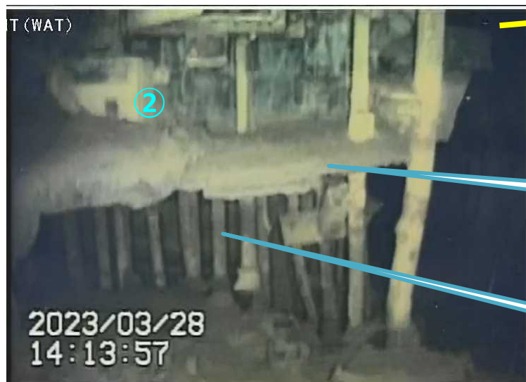
写真2.ペDESTAL開口部左下側壁面部
