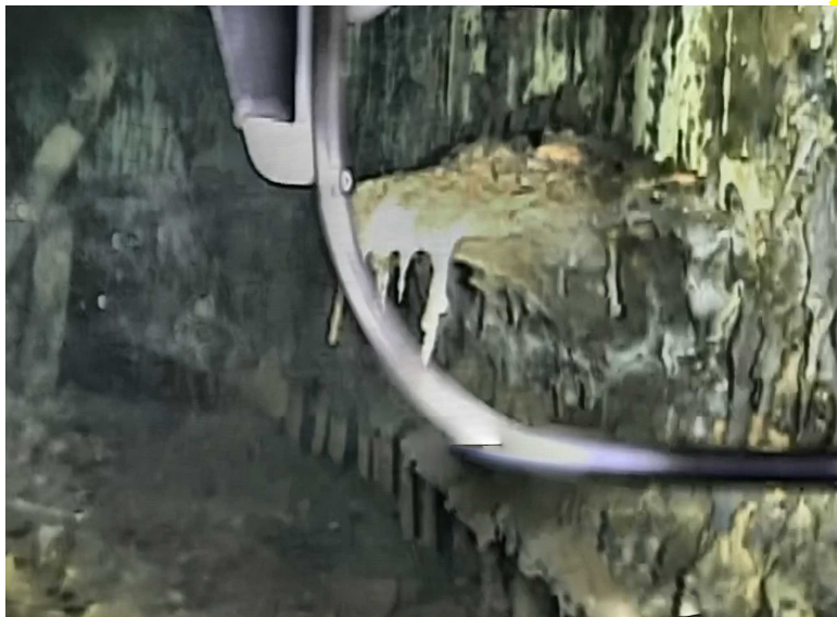
写真2 (パノラマ) 開口部右側の棚状堆積物
