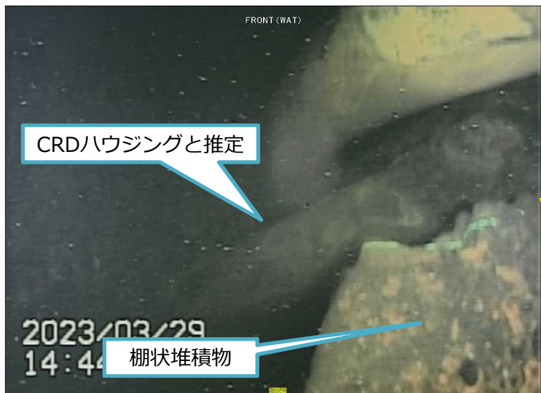
写真1 棚状堆積物の縁の状態 (その1)
