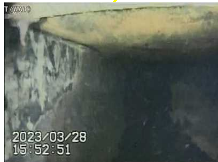
写真3 開口部内部の左側の壁の状態
