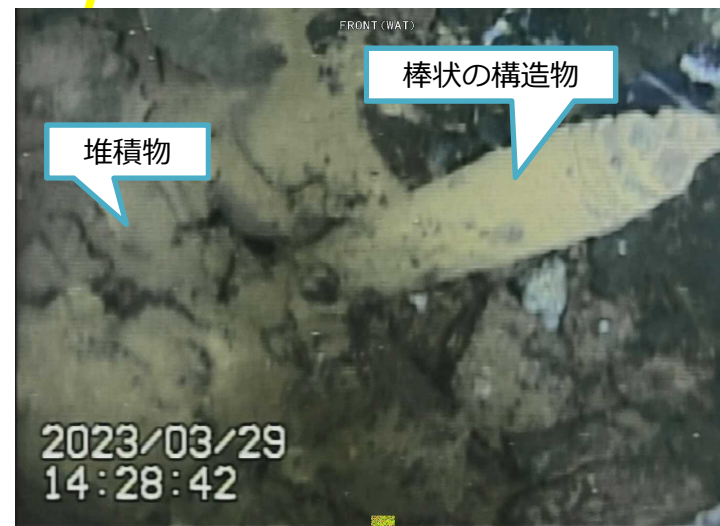
写真3.棒状の構造物(ペDESTAL底部)
