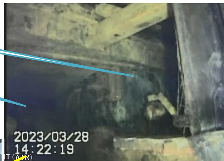
写真3.ペDESTAL開口部右上側壁面部
