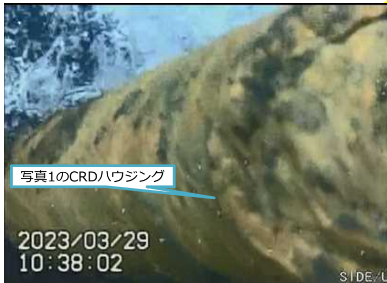
写真2 CRDハウジング断面
