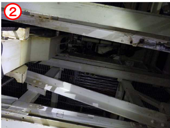
(RPV下部から見上げた様子)
