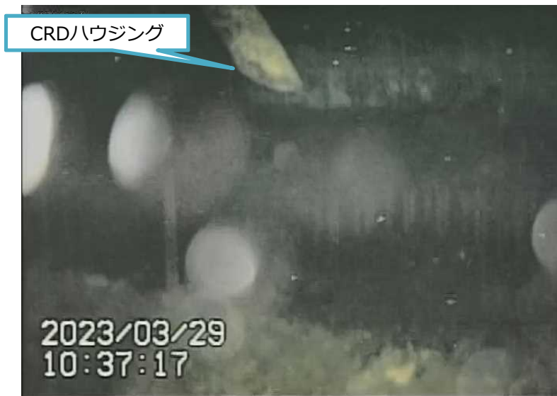
写真1 ペDESTAL内中心部で確認されたCRDハウジング (水中)
