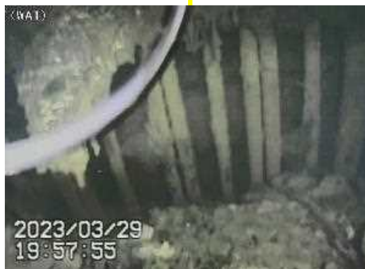
写真3 比較的に大きい棚状堆積物
