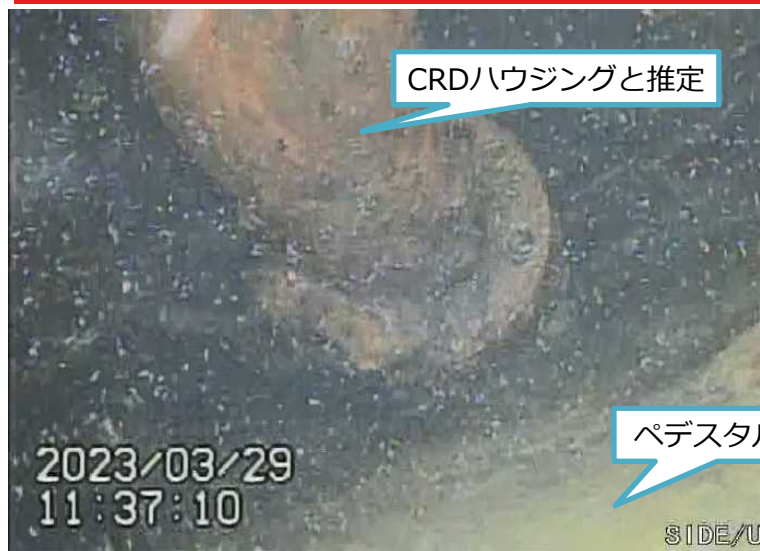
写真1. CRDハウジングと思われる構造物 (上部監視カメラで気中を撮影)
