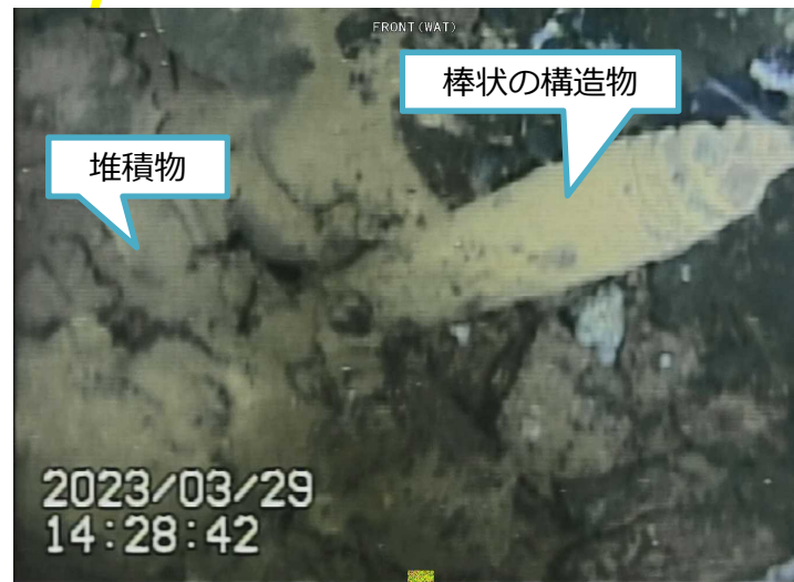
写真3.棒状の構造物(ペDESTAL底部)
