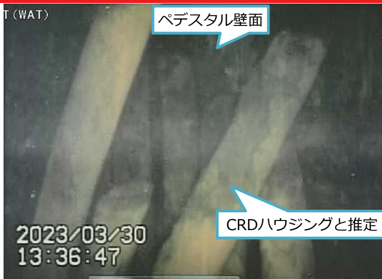
写真1. CRDハウジングと思われる構造物 (水中監視カメラで前方を撮影)
