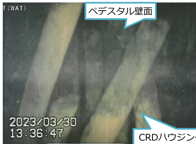
写真2. CR Dハウジングと思われる構造物
