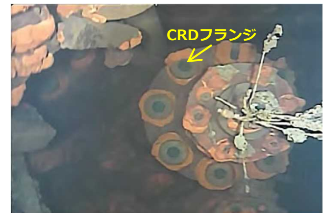
写真3. 3号機で確認されたCRD
