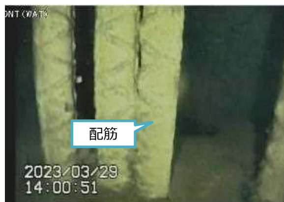
写真2. ポイント⑫ペDESTAL基礎部
