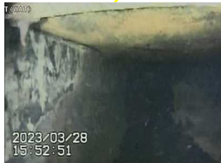
写真3 開口部内部の左側の壁の状態
