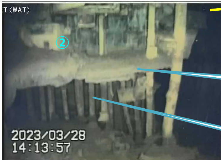
写真2.ペDESTAL開口部左下側壁面部
