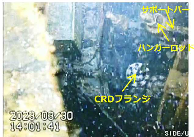
写真1. 1号機で確認されたCRD
