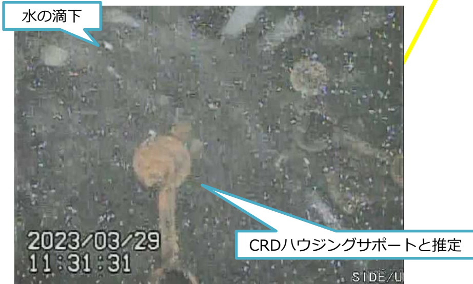
写真2. CRDハウジングサポートと思われる構造物 (上部監視カメラで気中を撮影)
