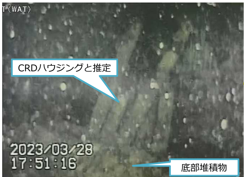
写真1. CRDハウジングと思われる構造物
