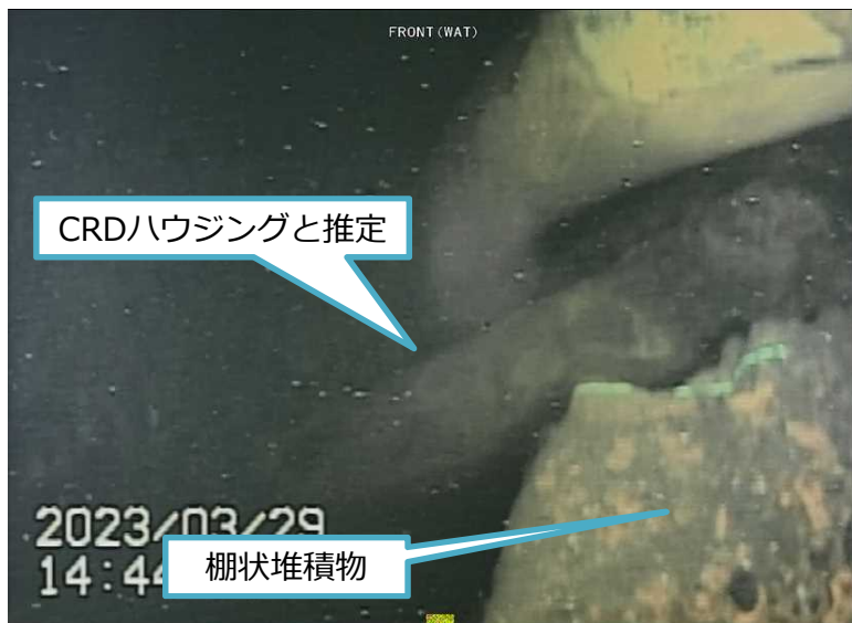
写真1 棚状堆積物の縁の状態 (その1)
