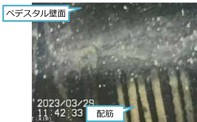
写真1. ポイント⑪ペDESTAL基礎部
