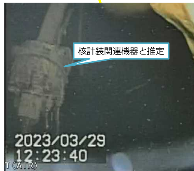
写真3. 核計装関連機器と思われる構造物 (気中監視カメラで気中を撮影)
