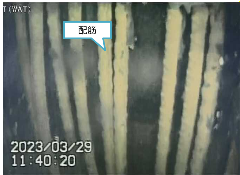
写真2.ペDESTAL内壁面部(下部)
