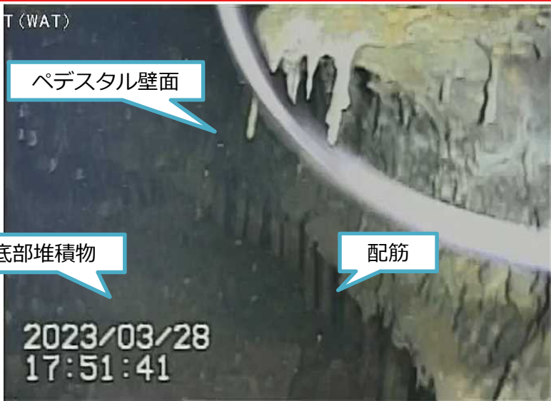
写真1.ペDESTAL内壁面部配筋
