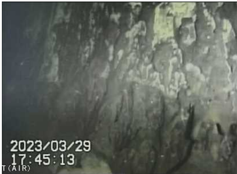
写真1 棚状堆積物のない壁面の状況
