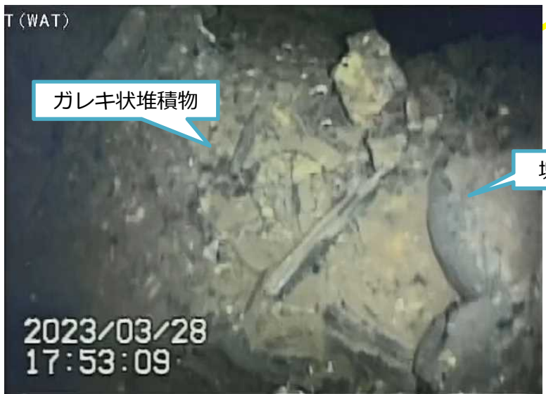
写真2.ペDESTAL内開口付近堆積物
