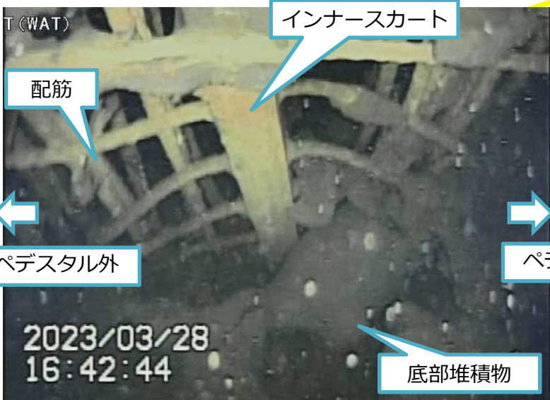
写真2.ペDESTAL開口左側配筋
