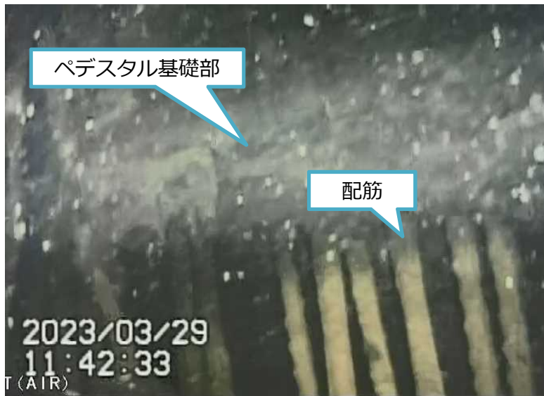
写真1.ペDESTAL内壁面部(上部)
