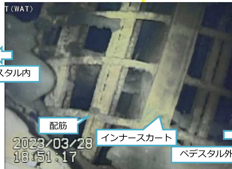
写真3.ペDESTAL開口右側配筋
