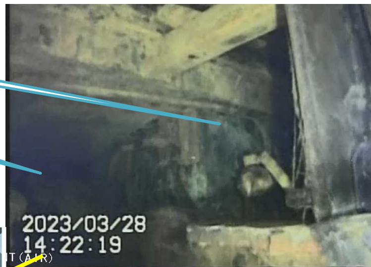
写真3.ペDESTAL開口部右上側壁面部
