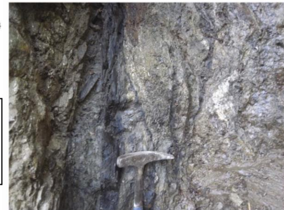
写真2 断層部の拡大
