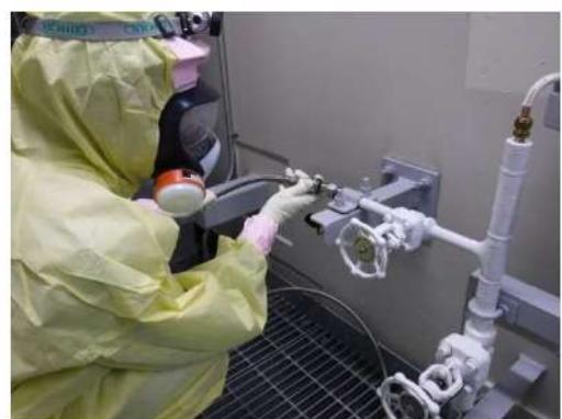
代替空気(窒素)供給用フレキシブル配管接続
