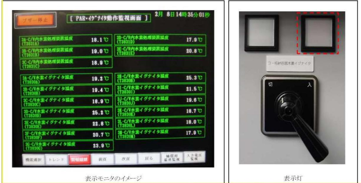
図2 格納容器水素イグナイト温度監視装置の概要
