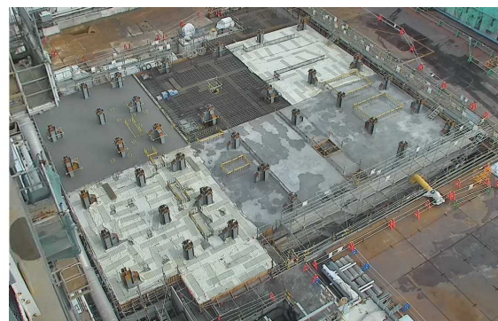
2号機原子炉建屋南側ヤード (構台基礎工事)
