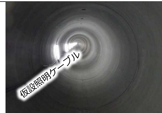
排水路推進トンネル完成状況
