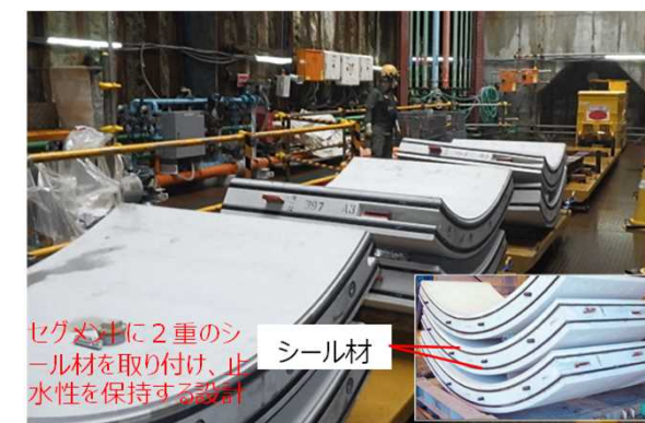
セグメント搬入状況
