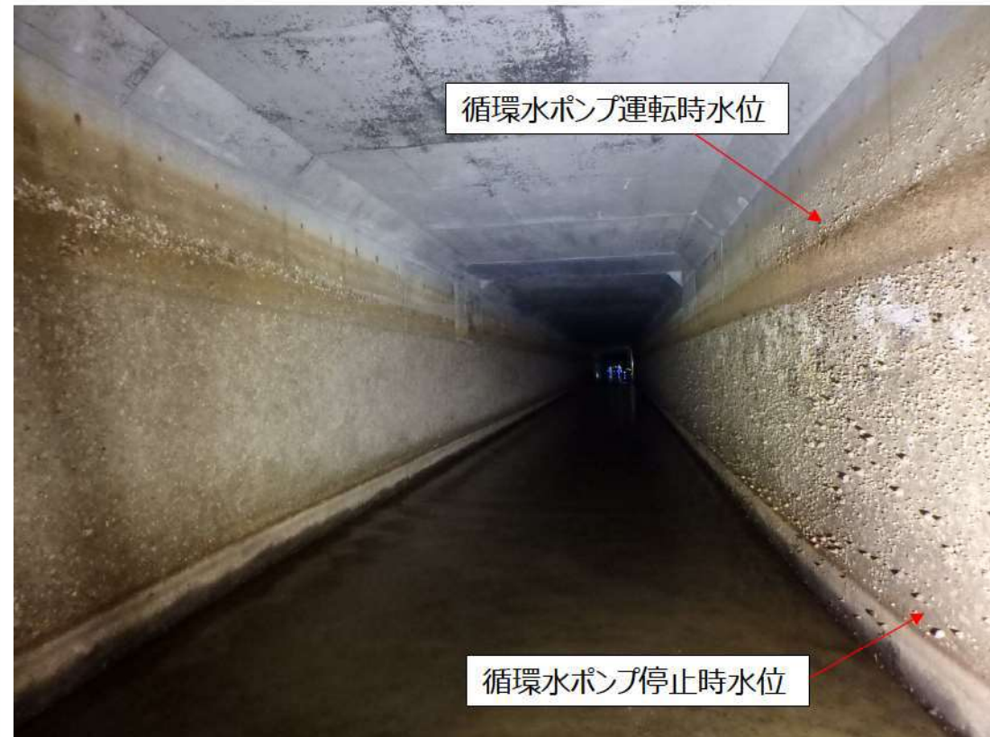
図1 1号炉放水路状況（2023年2月）
